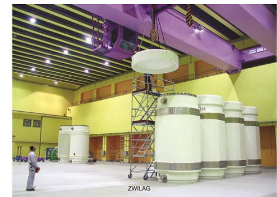
5 - Deposito temporaneo dei cask
